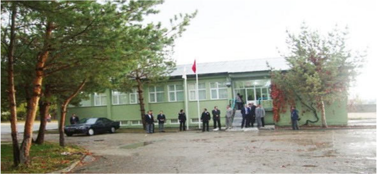
Resim 5. Malazgirt Meslek Yüksekokulu hizmet binası.
